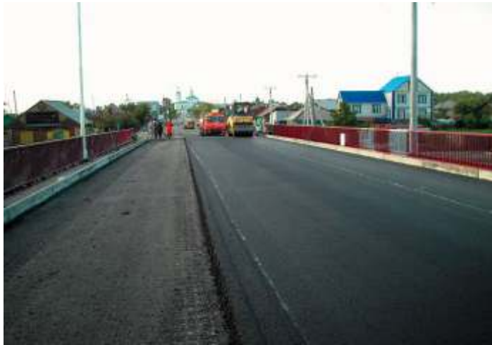
«Дорпромстрой» ведет работы на новом мосту через р. Ишим, стр. 146
